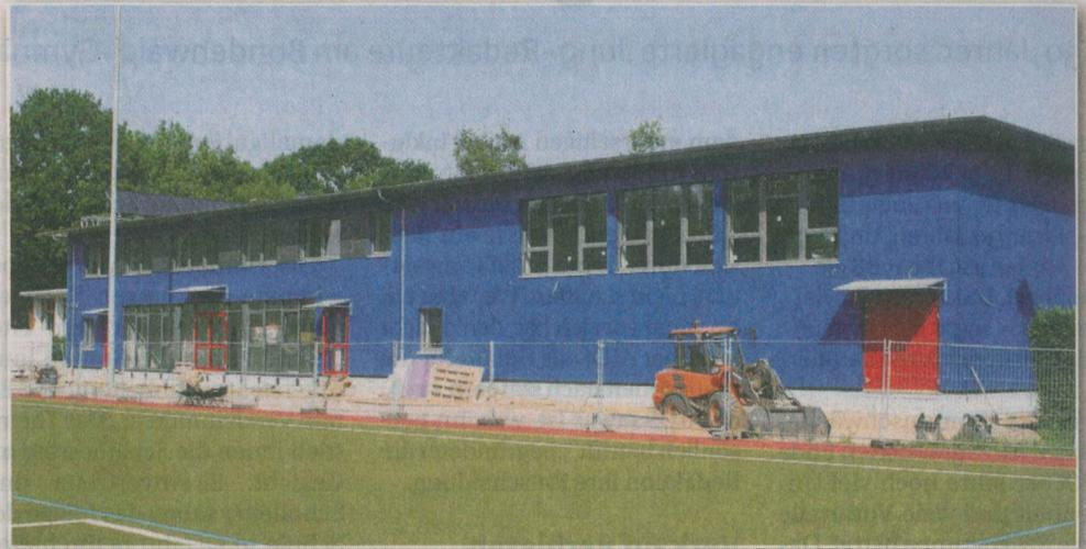
**Vorbildlicher Bau** 45,5 Meter lang und 15 Meter breit, die neue Halle am Sportplatz Bondenwald umfasst 951 Quadratmeter und wurde als Passiv- und Effizienzhaus 55 mit drei Lüftungsanlagen zur Wäremerückgewinnung sowie mit Solar- und Photovoltaikanlage ausgestattet *Foto: ap*
