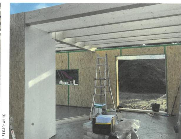
► Der Dachaufbau besteht aus einem wasserführenden Unterdach mit einer Membrane, einem Lüftungsraum und einer Streuschalung aus Lärche
